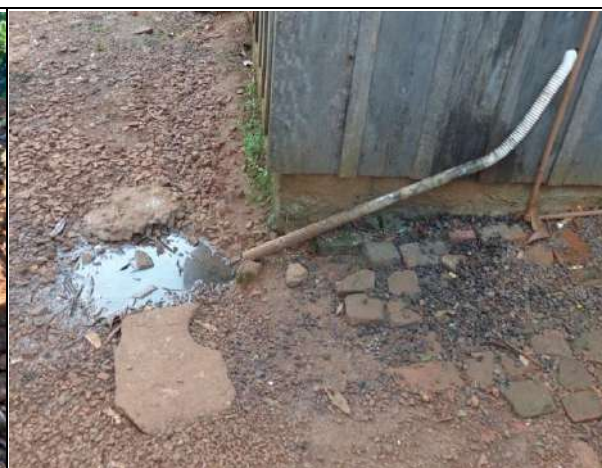
FOTO 05 – Fossa séptica FOTO 06 – Disposição final irregular
