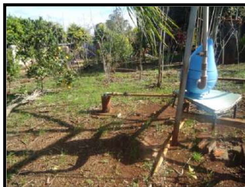
h) Poço da Linha 08 Sede
