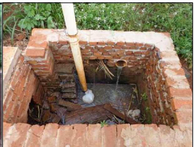
FOTO 06 – Drenagem/lançamento final
