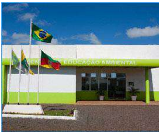
FOTO 01 – Central de Tratamento
