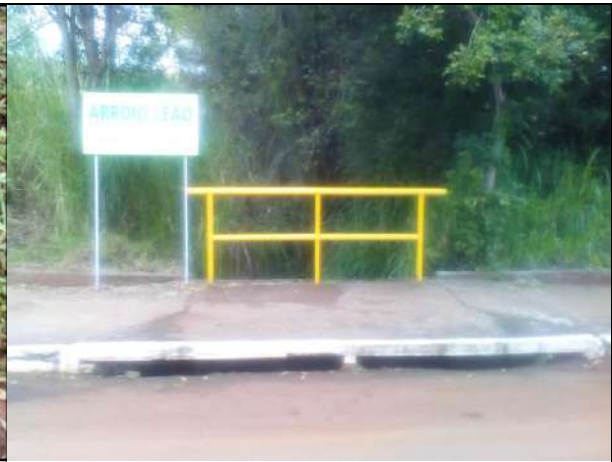
FOTO 02 – Boca de Lobo
