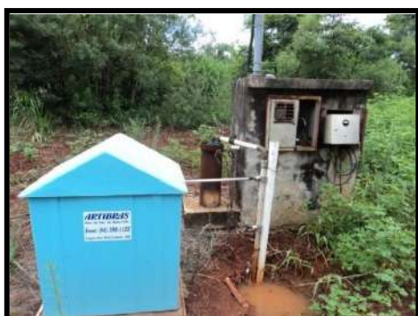
b) Poço Rua José Fischer
