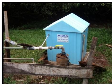
Cabe destacar que os quatro poços não possuem perímetro de proteção, e muitos deles apresentam tubulação do poço e de adução em condições precárias. Além disso, conforme informações da Prefeitura Municipal os poços possuem bombas reserva em estado de conservação deficitário.
